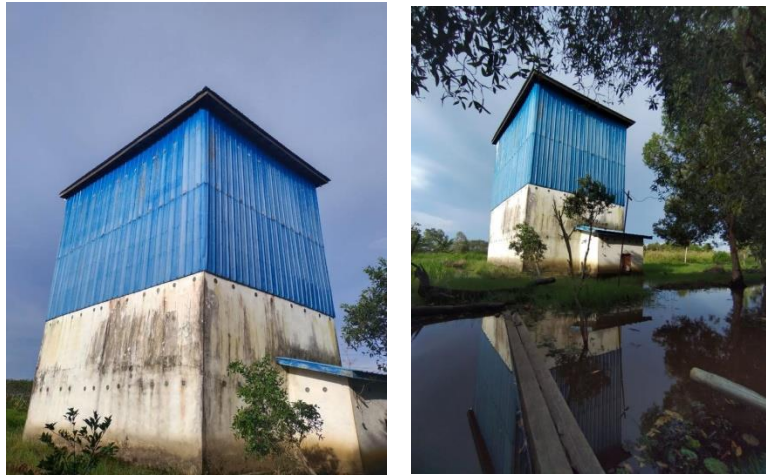
Gambar 5 rumah budidaya burung walet tembok bagian bawah beton bagian atas seng
