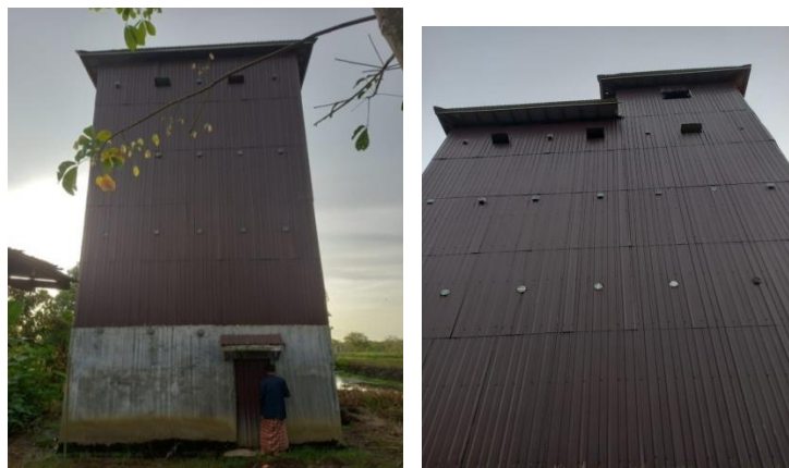
Gambar 4 Rumah Budidaya Burung Walet Tembok Full Atap Seng
