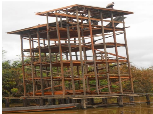
Gambar 4.13 Kerangka Kayu Rumah Budidaya Walet (sumber. https://udhargabangunan.com/konstruksi-rumah-walet.html/3 )
