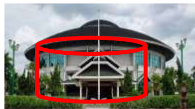
Gambar 11. Bangunan Gedung Sultan Suriansyah
