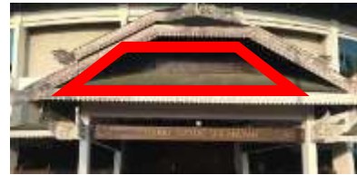
Gambar 10. Bagian Atap Depan Pintu
