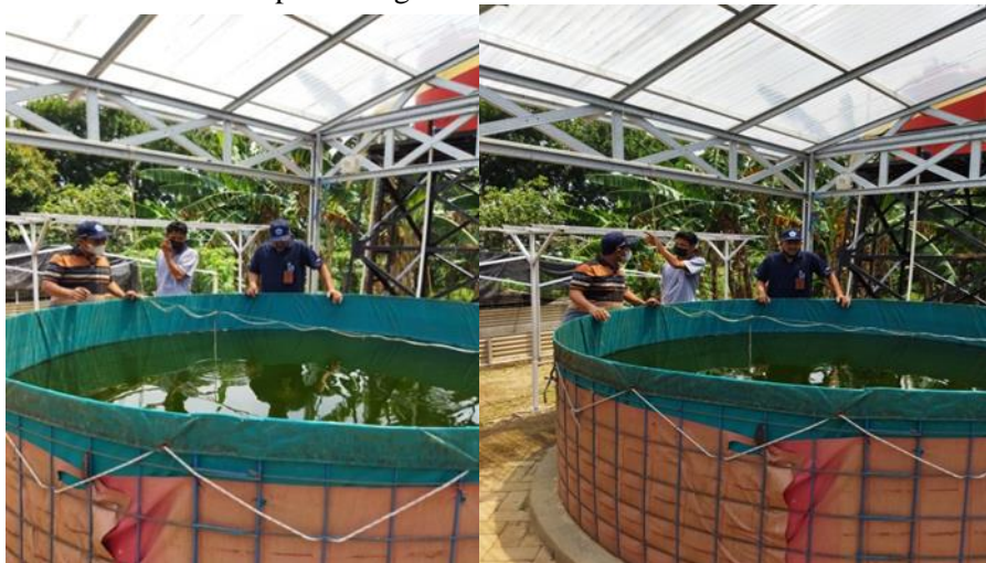
Gambar 1. Kolam terpal Ø3 m, konstruksi kolam terbuat dari besi dan memiliki pembuangan sentral dilengkapi instalasi paranet, listrik dan aerator
